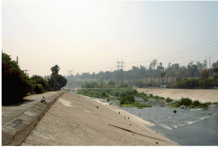
03 Im Bereich von Downtown L.A. (Glendale) ist der L.A. River ein breiter und betonierter Kanal (Bilder: Autorin)
