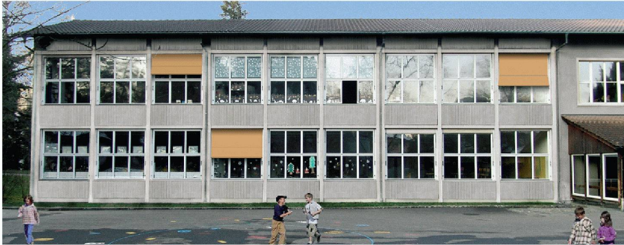
03 Die Sprossenfenster bleiben in der neuen Fassade der Klassentrakte erhalten (Weiterbearbeitung, Boltshauser Architekten, Zürich)
