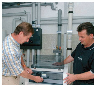
Eine Heizungssanierung dauert normalerweise nur wenige Tage.
