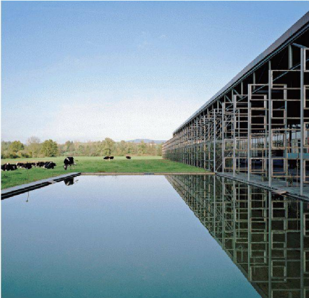
Die ausgezeichnete Fensterfabrik in Hagendorn (Bild: Lorence Bonvin, Genf)
