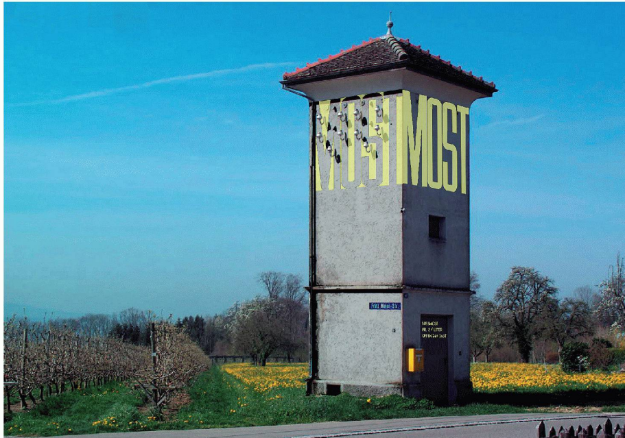
01 Obstanbau und Ausschank – das Projekt «Most Wanted» verwandelt die Trafostation ohne Umbauten in einen Mostturm (Mayo Bucher mit Drexler Guinand Jauslin Architekten, Zürich)
