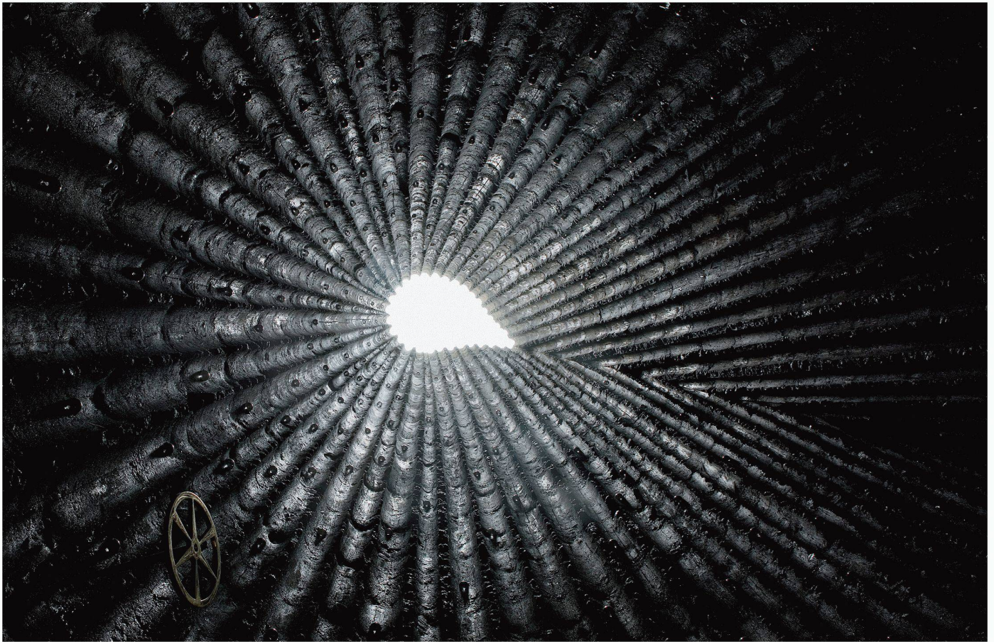
02 Die 112 Fichtenstämmen zeichnen sich nach der «Ausräucherung» im Innern ab. Der Blick zum tropfenförmigen Okulus streicht über das Meditationsrad aus poliertem Messing
