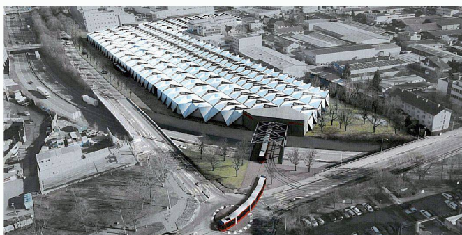
06 «Do-desu-ka-den». Kleinteilige Stahlbaumodule bedecken das Gelände wie ein Teppich (Ernst Basler + Partner, Atelier 5)
