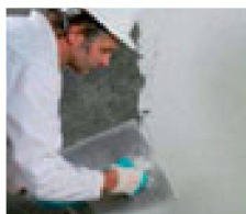
7. 13:00 Uhr: Ohne vorherigen Spritzbewurf kann als Oberflächenschutz der normal- oder schnellabbindende Remmers Sanierputz oder wahlweise auch die Remmers Schimmel-Sanierplatte aufgebracht werden.
