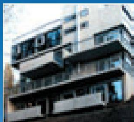
DEFH Bergstrasse, Zürich
