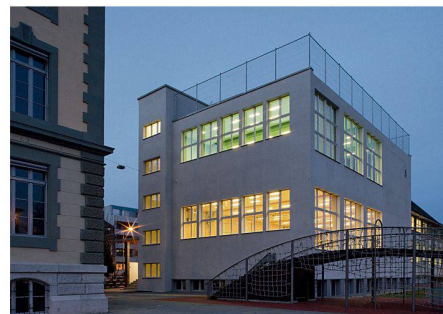
01 Sporthalle Neumarkt in Biel von 1932, saniert 2007 durch Spaceshop Architekten, Biel: Energetische Sanierung und denkmalpflegerische Ansprüche schlossen einander nicht aus (Bild: Yves André, St-Aubin)
