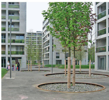
02 Die Ausnahme bestätigt die Regel: Die 2007 fertig gestellten Ersatzneubauten der Siedlung Werdwies in Zürich von Adrian Streich Architekten sind nicht nur in architektonischer Hinsicht herausragend, die Hülle erfüllt auch den Minergie-Standard. Das Projekt erhielt die Auszeichnungen «SIA Umsicht Regards Sguardi 2006/2007» und «best architects 08» (Foto: js/Red.)
