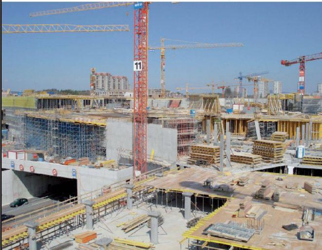
ca. 1'500 Betonstützen teilweise mit Betonpilze
