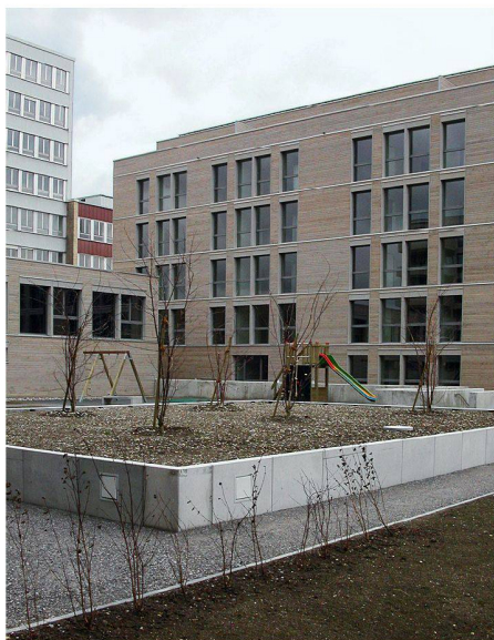
01 Siedlung Eulachhof, Winterthur: Für die Nullenergie-Überbauung wurde Holz in der Konstruktion, im Ausbau und an der Fassade verwendet (Bild: Michael Meuter, Lignum)
