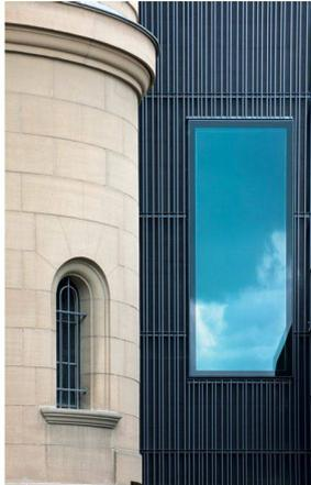
Die Stelenfassade aus vertikalen Stahl-Rundstäben als Rahmen für das Fenster, im Dialog mit der Vergitterung beim Altbau
