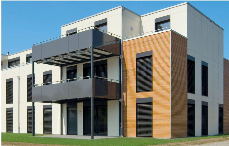
01 Wohn- und Geschäftshaus Châtel in Aadorf TG (Bild: Kifa AG)
