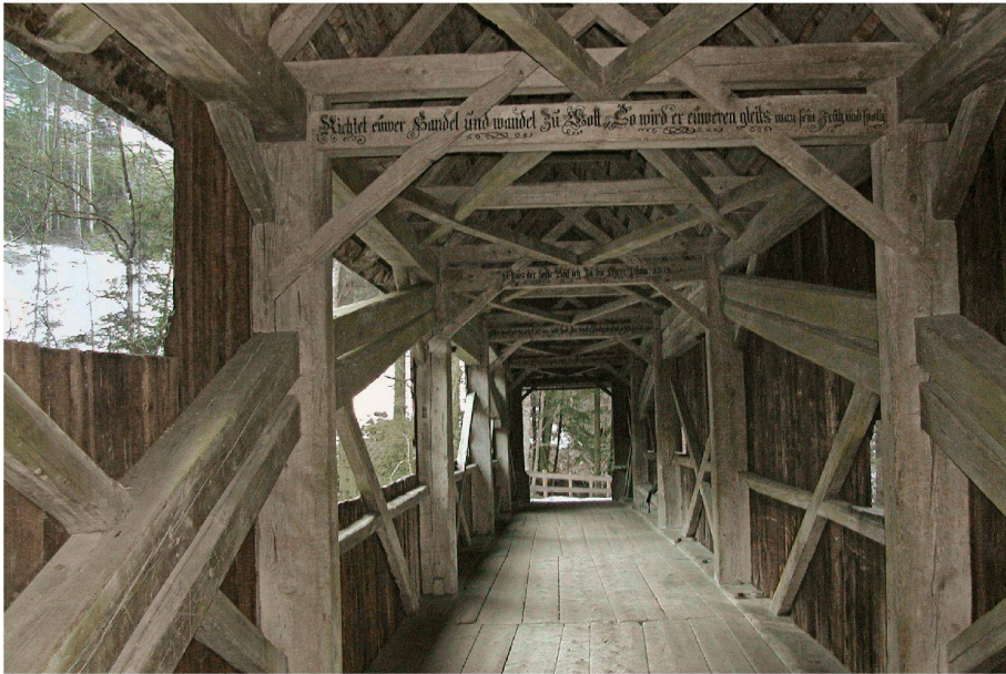
01 Von Hans Ulrich Grubenmann 1778 erstellte Brücke zwischen Hundwil und Herisau, die mit 29m Spannweite über die Urnäsch führt und noch bestens erhalten ist. Die Inschriften an den Querbalken haben ihr den Namen «Sprechend Brugg» eingebracht. Spruch im Bildvordergrund: «Richtet Euwer Handel und Wandel zu Gott, so wird er euwer Gleitsmann sein früh und spoth» (Foto: Grubenmann-Sammlung, Teufen)
