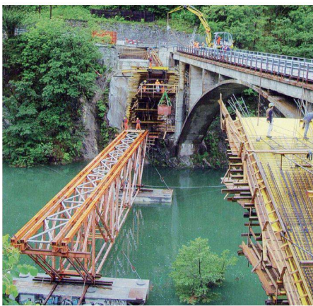
02 Das Lehrgerüst erlaubte einen Neubau neben der alten Brücke, unabhängig vom Pegelstand der gestauten Melezza (Bild: Dario Somaini, Grono)
