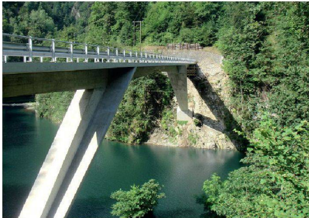
01 Sprengwerk der Melezzaabücke im Centovalli (Bild: Pedrazzini / De Giorgi & Partners)
