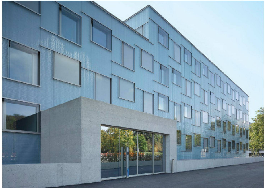
01 Axpo Verwaltungsgebäude in Baden, erstellt nach den Zielwerten des SIA Effizienzpfades Energie (Architektur: Meier Leder Architekten, Baden, Foto: Roger Frei, Zürich)
