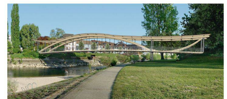
11 Gedeckte Holzbrücke mit unterspannter Bogenkonstruktion
