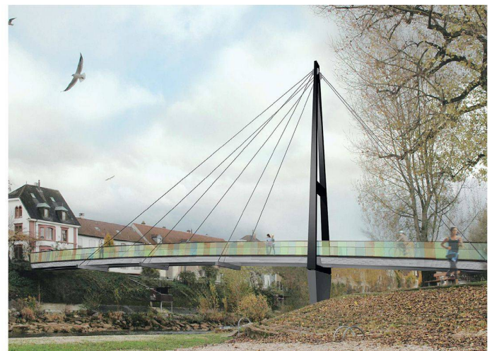
05 Schrägseilbrücke mit A-förmigem Pylon, drei Abspannungen im Hauptfeld (Spannweiten 17.7, 11.0, 13.0 und 12.7 m) und konstanter Trägerhöhe
