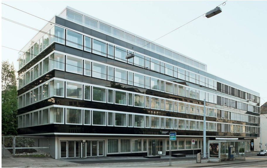
01 Zwei Generationen Glasfassaden (Fotos: Dominique Marc Wehrli)
