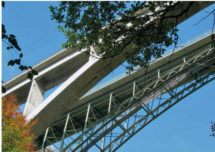
01 Schwarzwasserbrücke (Foto: Eugen Brühwiler)
