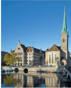
Stadthaus Zürich nach der Sanierung, Oktober 2010 (Foto: Roger Frei)
