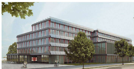
16 «Meander»: Unterschiedlich hohe Gebäudeteile bilden einen mäandrierenden Baukörper. Der solide Sockel beschränkt den Bezug zum See (D. Jüngling und A. Hartmann Architekten)
