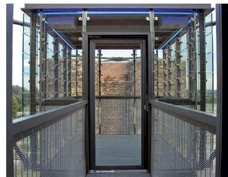
03 Der Anbau der Aussichtskanzeln wurde im Rahmen der IBA Fürst-Pückler-Land realisiert
