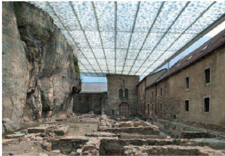
01 Auszeichnung: Im Walliser Kloster Saint-Maurice schützt ein abgehängter, transluzent eingedeckter Stahlrost die Ruinen aus dem 4. Jh. vor Steinschlag (Foto: Thomas Jantscher)
