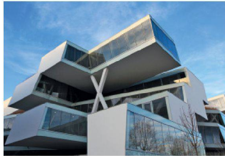
02 Auszeichnung: Verdreht gestapelte Fachwerk- und Vierendeelträger bilden das komplexe Hybridtragwerk des Business Center in Allschwil BL (vgl. TEC21 3-4/2010) (Foto: Actelion Ltd.)
