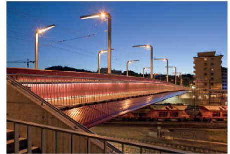
03 Auszeichnung: Die Langensandbrücke in Luzern spannt mit zwei Hohlkastenträgern im Verbund mit der Betonfahrbahnplatte 80 m stützenfrei über das Gleisfeld (Foto: Yves André)
