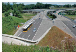
A4/A3 western bypass Zurich Baudirektion Kanton Zürich— Tiefbauamt, Projektieren und Realisieren Zurich
