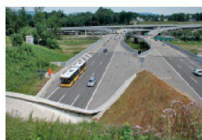
A4/A3 western bypass Zurich Baudirektion Kanton Zürich— Tiefbauamt, Projektieren und Realisieren Zurich
