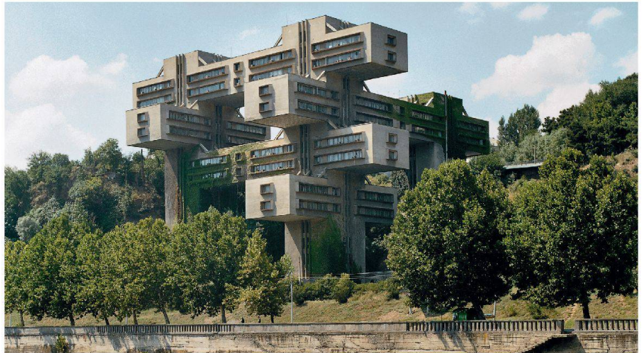
01 Ministerium für Strassenbau, Tiflis, Baujahr 1975 (Foto: Frédéric Chaubin)
