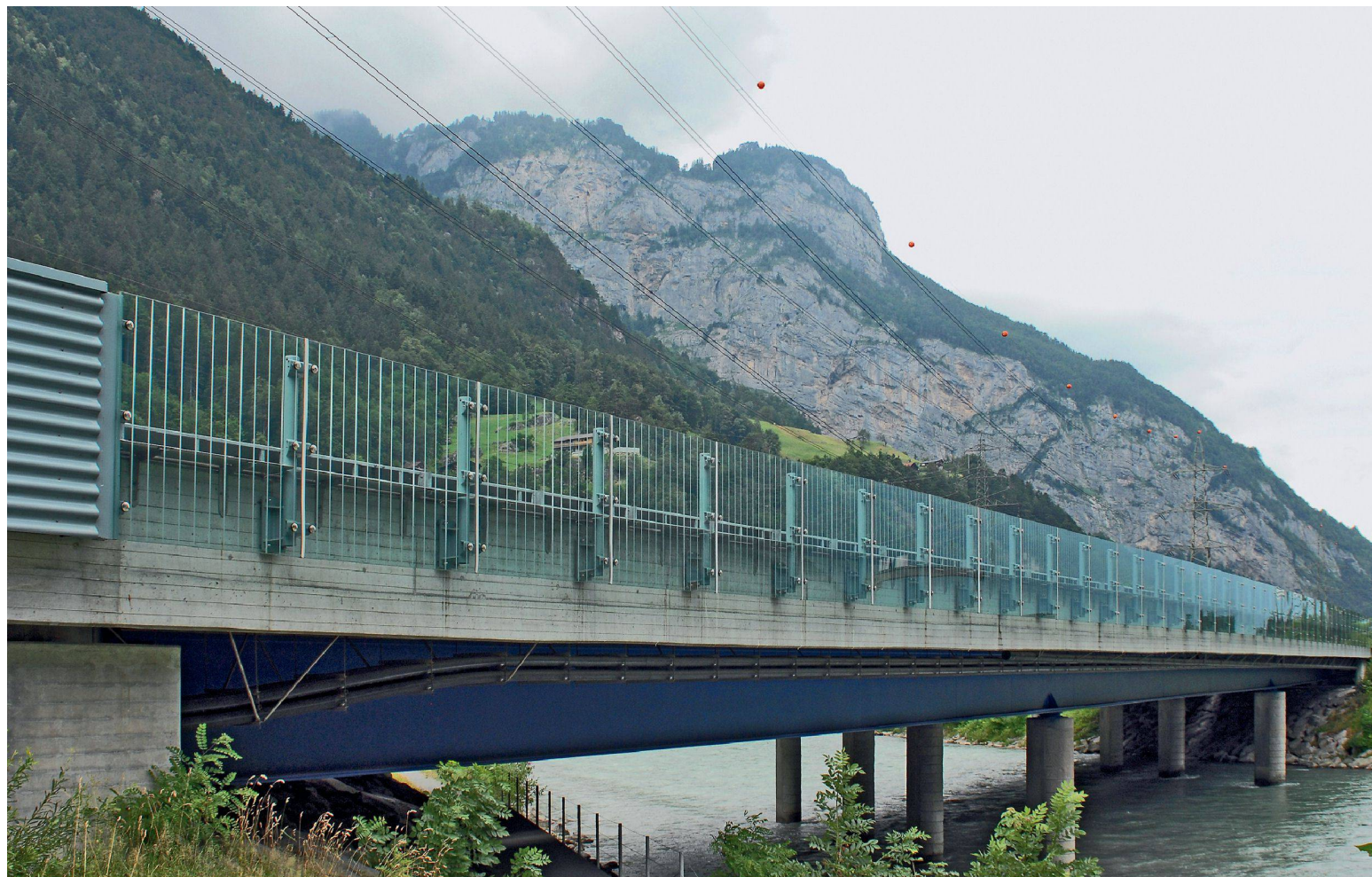
01 Der neue Drain-Asphalt und die Lärmschutzwände reduzieren die Lärmbelastung im Reusstal / Le nouvel asphalte drainant et les parois anti-bruit réduisent les nuisances sonores dans la vallée de la Reuss / Il nuovo asfalto drenante e le barriere antirumore riducono l'inquinamento acustico nella Reusstal (Foto/photo/foto: Joe Müller)
