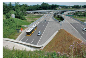
A4/A3 Westumfahrung Zürich Baudirektion Kanton Zürich – Tiefbauamt, Projektieren und Realisieren Zürich
