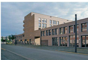
Null-Energie-Wohnüberbauung Eulachhof Architekturbüro Prof. Dietrich Schwarz/GlassX Zürich
