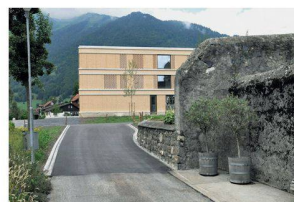
Zentrum für Alterspsychiatrie St. Pirminsberg, Pfäfers huggenbergerfries Architekten Zürich
