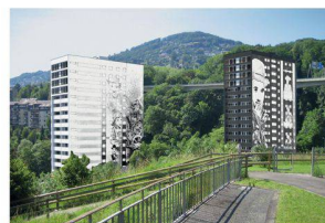
Rénovation d'immeubles énergétiquement durable Architectes Patrick Chiché Lausanne
