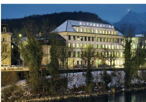
Alternative Bank Schweiz – ein Umbau für die 2000-Watt-Gesellschaft Metron Architektur Brugg
