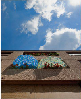
Alterssiedlung Hardau, Zürich: Zwei Freundinnen treffen sich hier oft auf dem Balkon. Die Titelbilder dieser Ausgabe und die Bilder in den beiden Fachbeiträgen stammen aus einer Publikation der Stiftung Alterswohnungen der Stadt Zürich SAW 1 (Foto: Dominique Meienberg)
