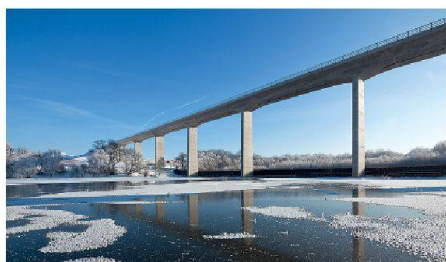
02 Nahezu fugen- und lagerlos: 576,5 m lange Eisenbahnbrücke über das Scherkondetal in Thüringen (Fotos: Deutscher Brückenbaupreis)
