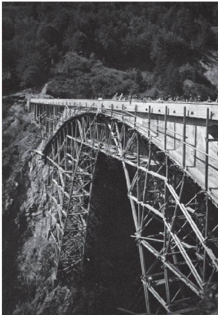
02 Salginatobelbrücke zwischen Schiers und Schuders von Robert Maillart, 1929–1930
