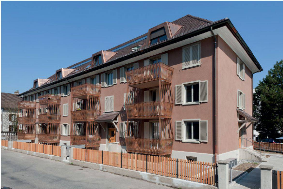
01 Die Balkone sind als feingliedrige Elemente aus Flachstahlprofilen vor die Südfassade gestellt. Der zusätzliche Aussenraum erhöht die Wohnqualität (Fotos: Christian Schwager)
