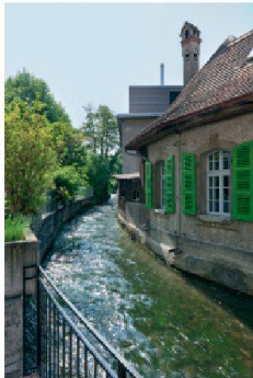
Der Mülibach ist Teil des Kanalsystems von Burgdorf. Er bereichert das Stadtbild, bietet spezielle Wohnlagen und liefert Wasser für die Turbinen der Kleinwasserkraftwerke (Foto: Hannes Henz)
