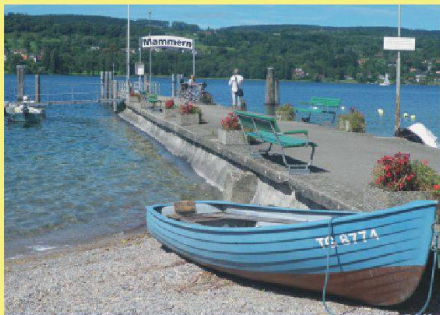
01 Die ehemalige Anlage bestand aus einem Damm und einer vorgelagerten Anlegeplattform (Foto: Margrith Pfister)
