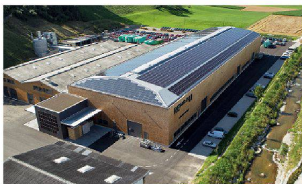
02 Kategorie Neubauten: Das Holzwerk Renggli in Schötz LU erreicht mit seinen total 303 kWp leistenden PV-Anlagen auf dem Dach und an der Südfassade 95 % Eigenenergieversorgung.
