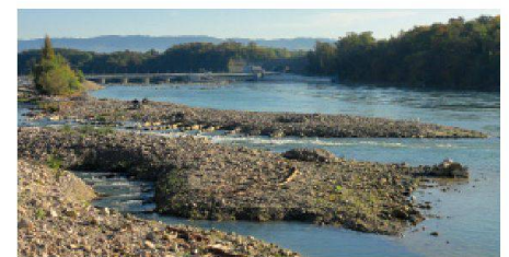
01 Fischtreppe beim Kraftwerk Rheinfelden. (Foto: nc)
