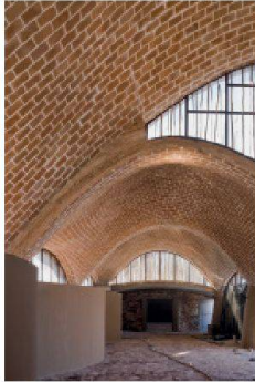
Untersicht des gemauerten Deckengewölbes des Mapungubwe Interpretation Centre im gleichnamigen Nationalpark in Zimbabwe. Architekt: Peter Rich, Johannesburg (Foto: Iwan Baan)
