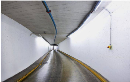
Einfahrt in das Zürcher Parkhaus Hohe Promenade vor den Umbauarbeiten (Foto: Luca Zanier)
