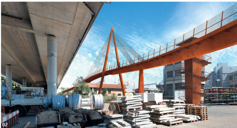
01–04 «Durchblick» (Ulaga/Nord): Die beinahe 60m weit gespannte Schrägseilbrücke überbrückt ein Gebäude und die Bahnlinie. Sie ist aus wetterfestem Stahl konstruiert und schliesst an beiden Enden je an eine zwei- resp. eine dreifeldrige Balkenbrücke an. Die sorgfältig gestaltete Oberfläche gibt dem Bauwerk ein einheitliches Aussehen (alle Pläne + Visualisierungen: Projektverfasser)
