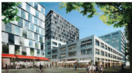
01 Unmittelbar neben dem Hauptbahnhof Zürich entsteht derzeit entlang der Europaallee ein neuer Stadtteil. Auf dem Baufeld H soll ein Vorzeigeprojekt punkto Nachhaltigkeit entstehen (Bauherrschaft: SBB, Planer: e2a eckert eckert architekten ag, Zürich, Basler & Hofmann, Ingenieure und Planer AG, Zürich) (Visualisierung: e2a Architekten)
