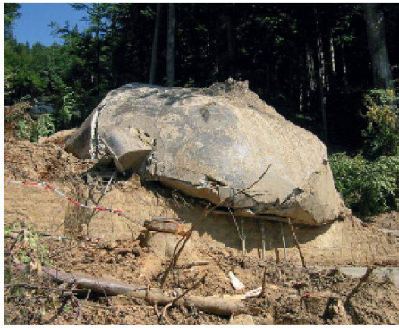
01 Durch einen Erdbeben zerstörtes Wasserreservoir (Foto: Hetzer, Jäckli und Partner AG)
