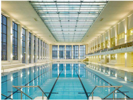
Das Glasfaltdach der Schwimmhalle: eine «Erleuchtung» nach den Jahrzehnten, da eine untergehängte Decke den Lichteinfall reduzierte. (Foto: Hannes Henz)
