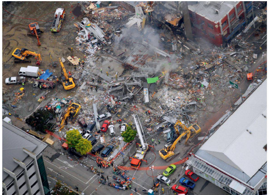
02 Luftaufnahme des zerstörten CTV-Gebäudes. (Foto: Keystone, AP New Zealand Herald, Sarah Ivey)
