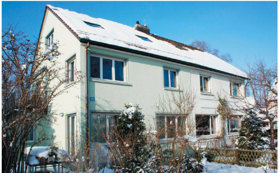
01 Optisch ist zwischen der sanierten, vorderen Doppel-Einfamilienhaushälfte fast keine Unterschied auszumachen gegenüber der hinteren unsanierten Hälfte. (Fotos: Autor)
