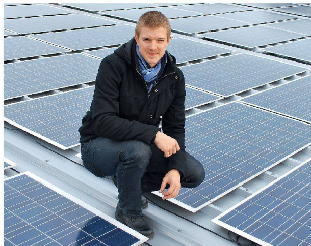
Ingenieur Patrick Schulthess auf dem Solardach der Landi Klingnau
