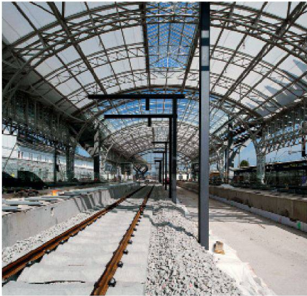
Tonnendach im Salzburger Hauptbahnhof mit textilem Sonnenschutz von Sefar. (Foto: Sefar)
