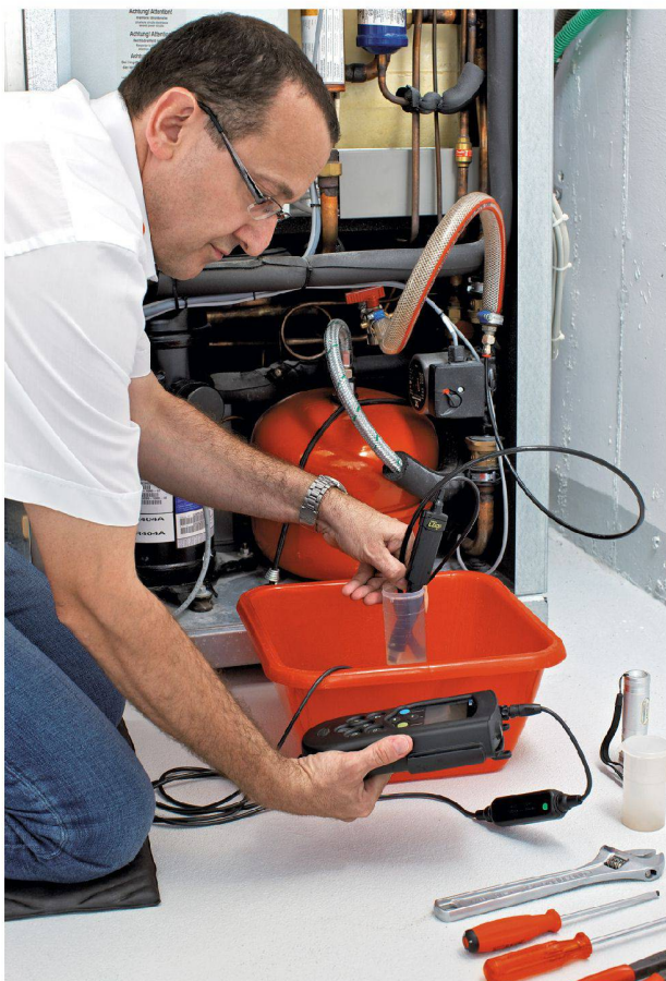
Sorgfältige Wasseranalyse vor der Sanierung.
