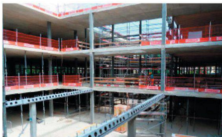
Deltabeam-Stahlprofile von Peikko im Einsatz.
