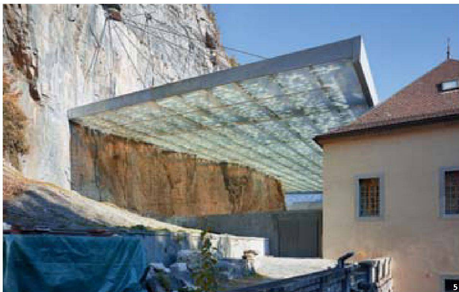
5 Die halbtransparente Eindeckung filtert das Licht. | La couverture translucide filtre la lumière. | La copertura traslucida lascia filtrare la luce. 6 Die Steine auf dem Dach erzeugen ein Gegengewicht bei Windbelastung. | Les pierres sur la toiture contrebalancent les effets du vent. | Le pietre sul tetto creano un contrappeso per contrastare il carico del vento.
