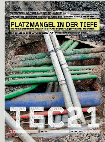
22/2013: Platzmangel in der Tiefe • Unten wird's eng • Pilzdach auf dichtem Untergrund • Wenig Raum für Baugruben
